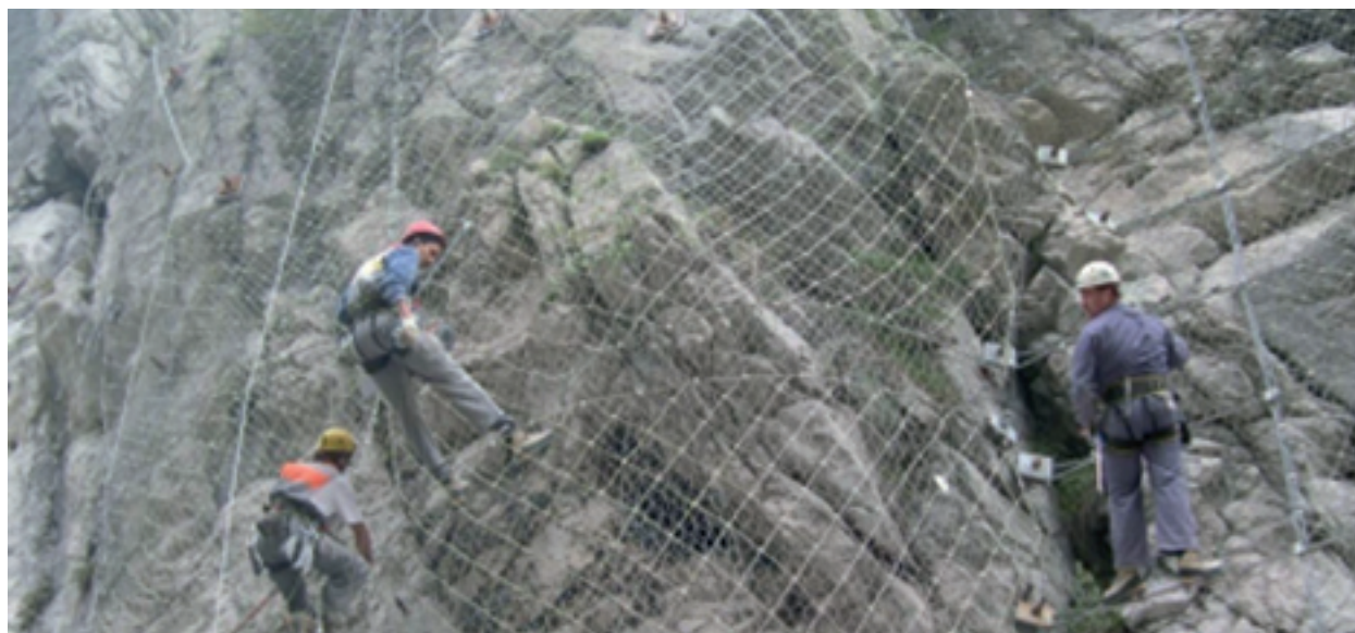
Messa in sicurezza di parete rocciosa
