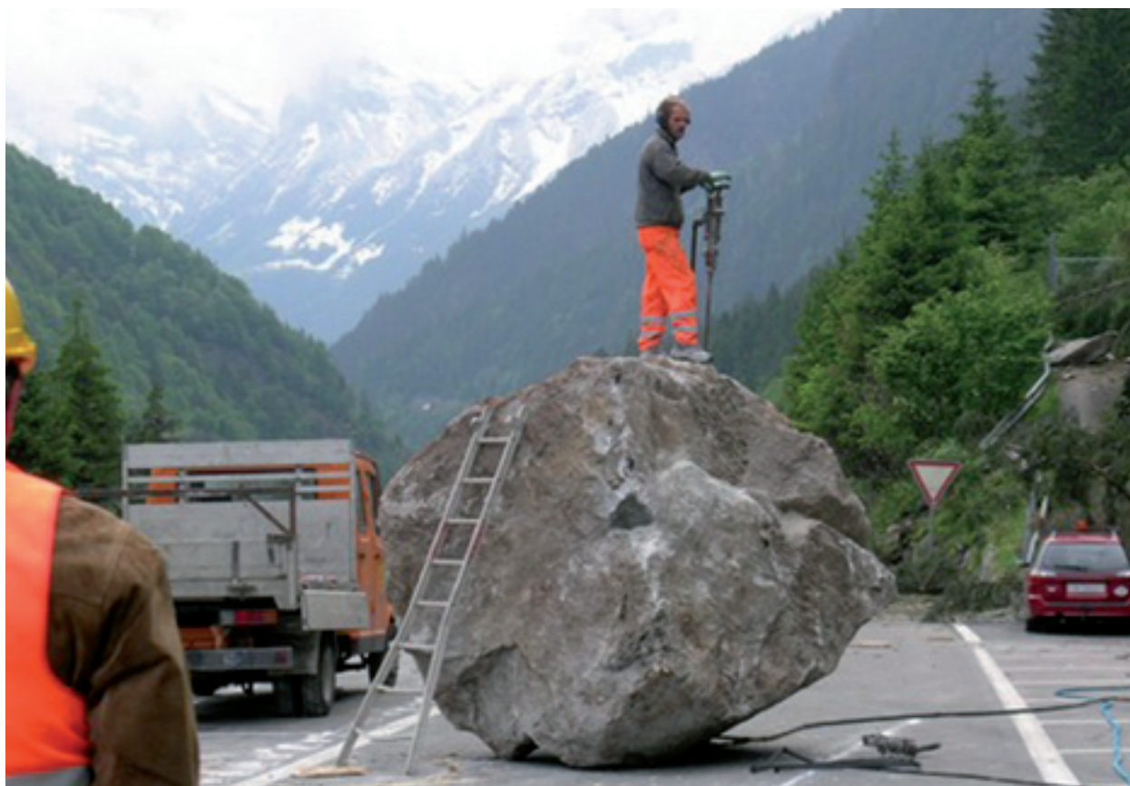
Attività di ripristino della viabilità a seguito di una frana di crollo
