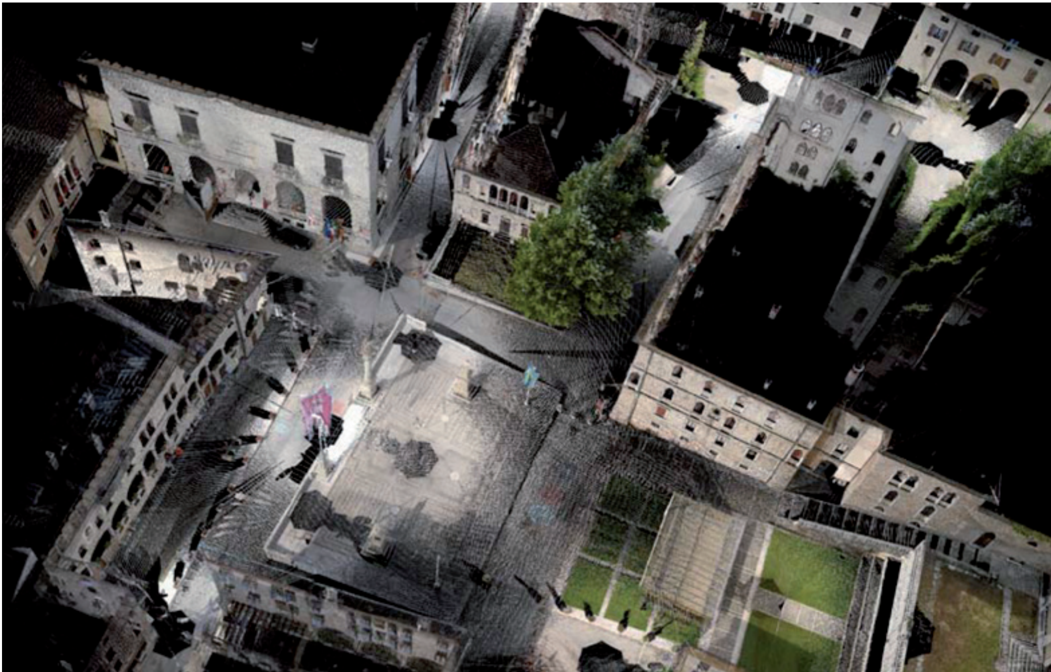
Il rilievo con laser scanner terrestre di una zona del centro storico di Feltre
